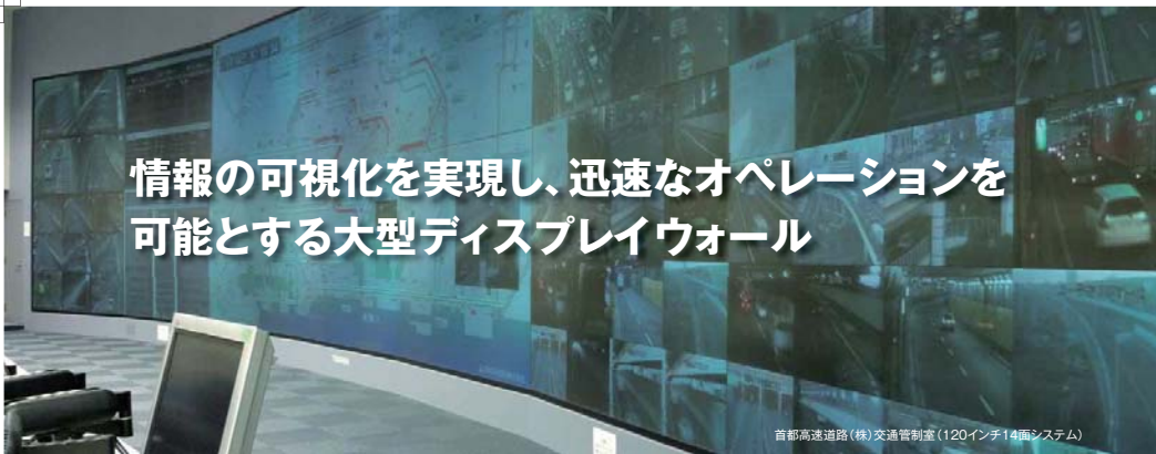
首都高速道路(株)交通管制室(120インチ14画システム)
